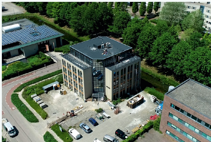
3 warmtepompen appartementen in Amersfoort. Aquarea
