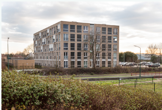
75 Warmtepompen appartementen Cuijk. Aquarea All in One
